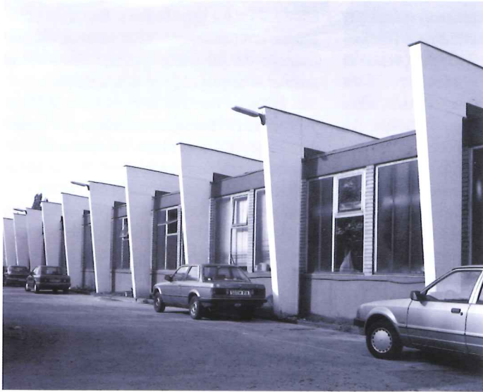
Modernes Fabrikationsgebäude der Scherenfabrik Fa. Kretzer, 1993.
