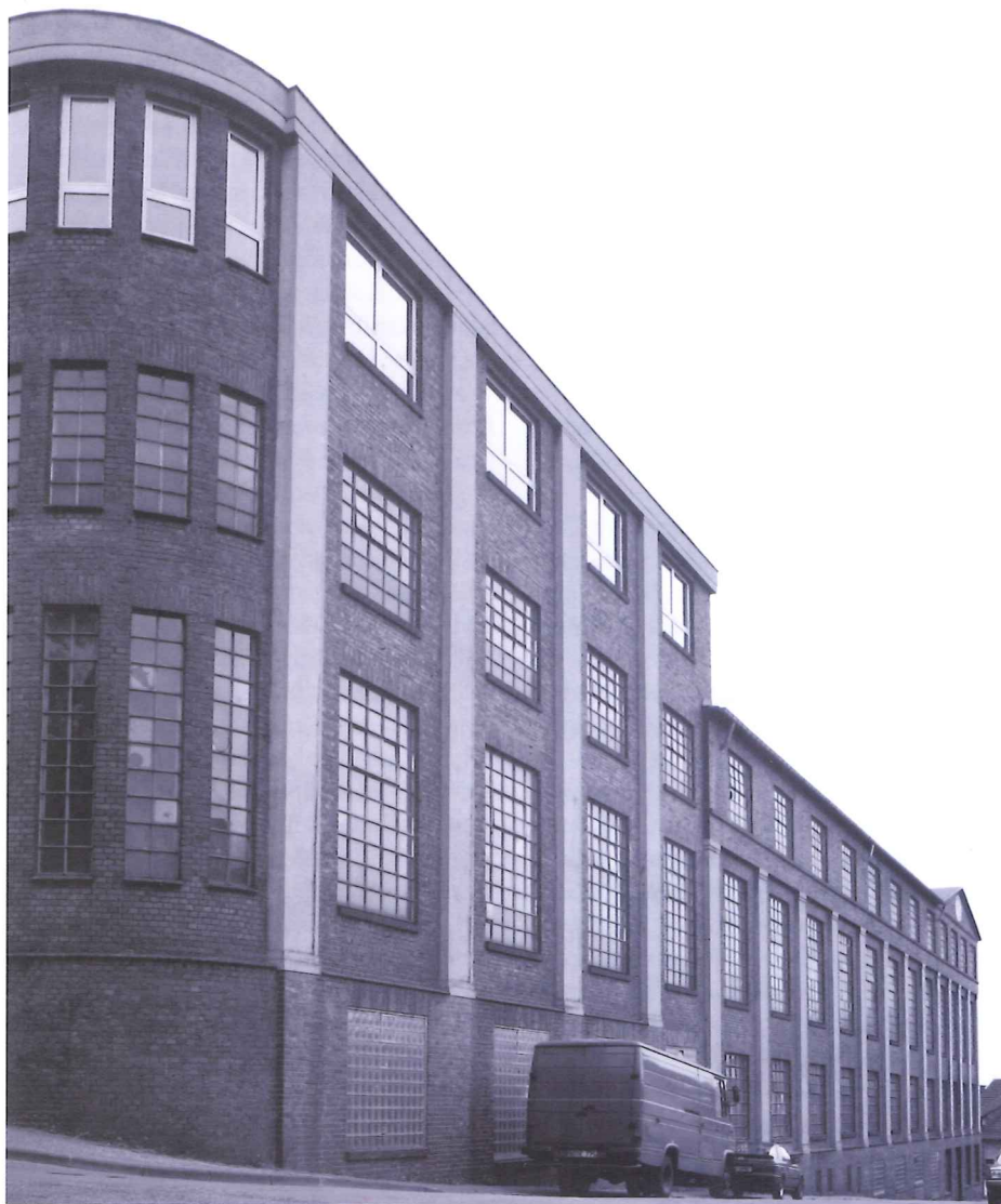
Hauptgebäude der ehemaligen Maschinenfabrik Fa. Klopp an der Obenitterstraße in Solingen-Wald.
