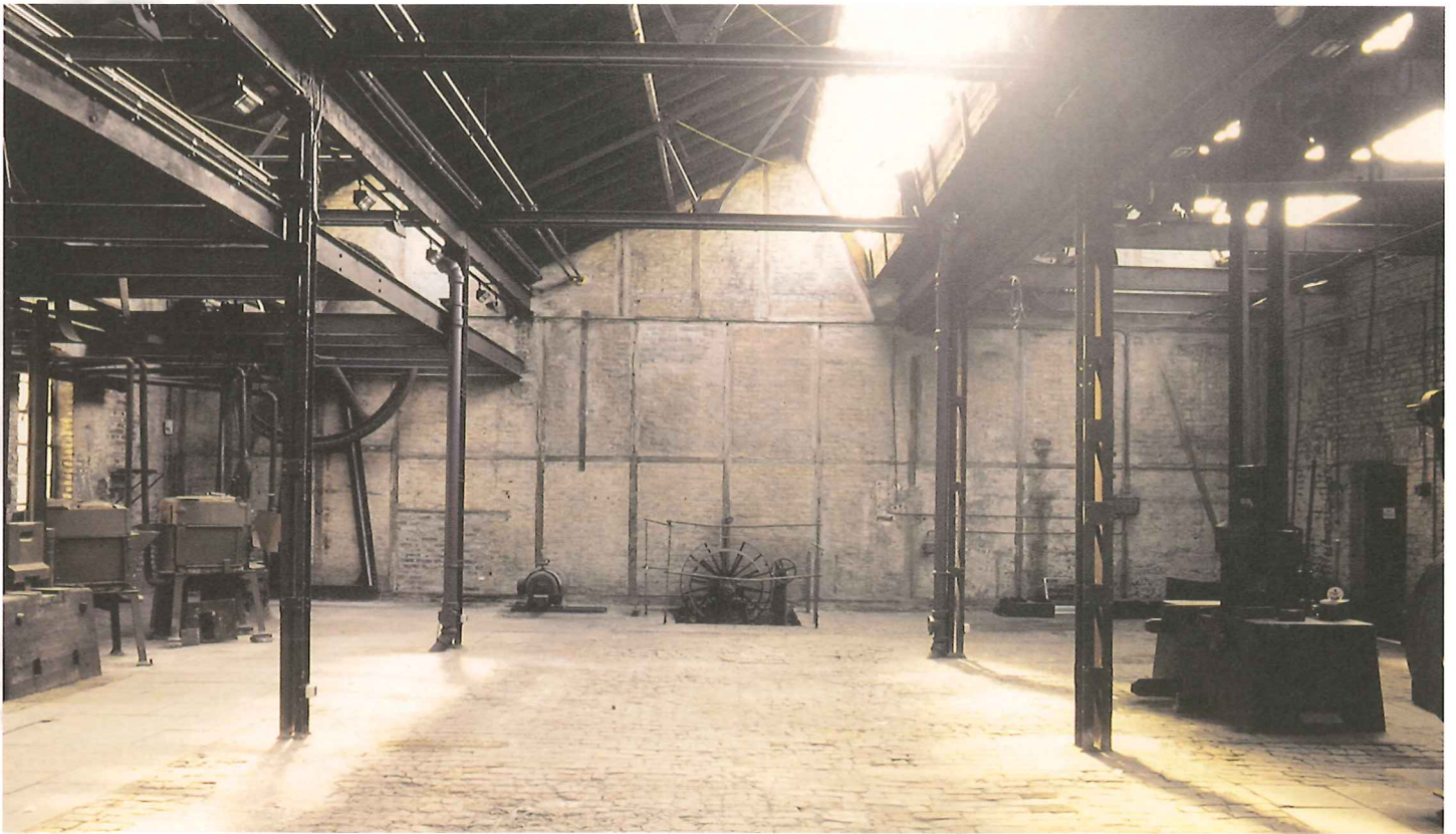
Die neue Eingangshalle im Innenraum von 1915, noch ohne Einrichtung
