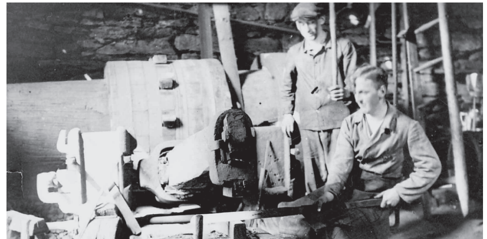
(7) Vorschmieden des Stahls für die Remscheider Werkzeugindustrie in einem Wasserhammer, o.J., um 1880
