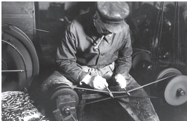
(14) Der Augenpliester war ein auf die Scherenaugen spezialisierter Schleifer. The Augenpliester was a grinder who specialized in finishing the eyes of the scissors. Le polisseur d'anneaux de ciseaux était un émouleur spécialisé dans le polissage des anneaux de ciseaux. El „Augenplister“ era l'artesà especialitzat en polir els ulls de les tisores.
