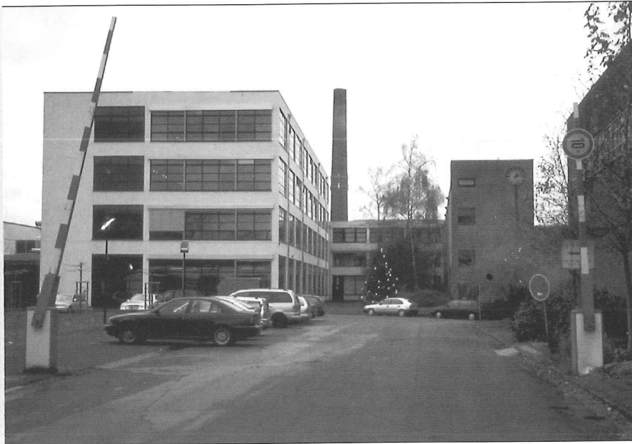
▲ Als Textilfabrik unverändert in Funktion sind die Bauten der Vereinigten Seidenweberei in Krefeld, entworfen vom Architekten Mies van der Rohe. (Foto: Detlef Stender, 2001)
