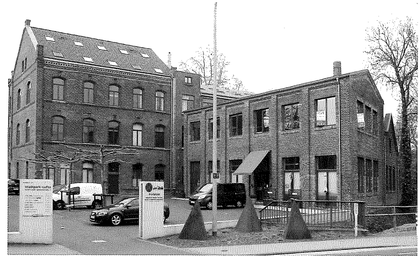
Abb. 10: Die Tuchfabrik Schiffmann in Euskirchen, die Anfang der 1960er-Jahre schließen musste, beherbergt heute Wohnungen, Büros und ein Restaurant. (Foto: LVR-Industriemuseum, D. Stender)
