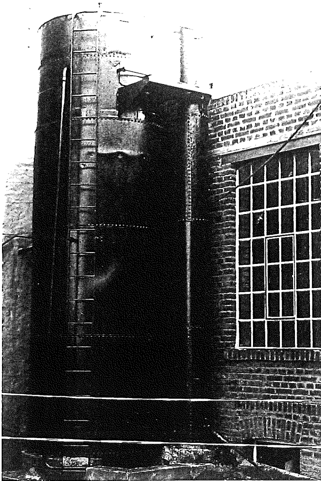
Abb. 12. Als Oberflächenbehandlung des Wasseraufbereitungstanks wurde ein „klassischer“ Korrosionsschutz nach industriellem Standard vorgenommen.
